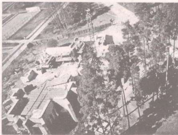
Строительная площадка. Вид сверху.
